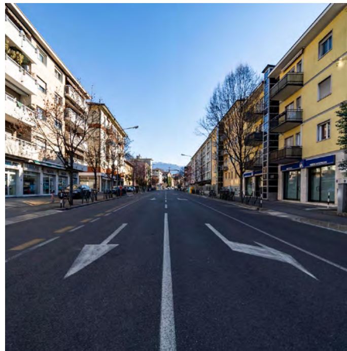
Nuova pavimentazione stradale Viale Druso, Bolzano (BZ)
